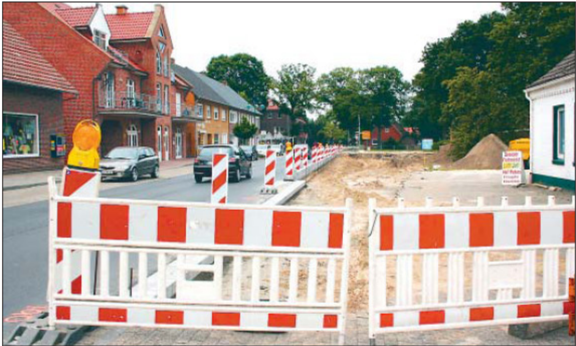
Ende August wird der neue Busbahnhof an der Poststraße in Betrieb genommen.
